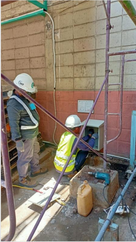
(Perbaikan Penyalur Petir)
