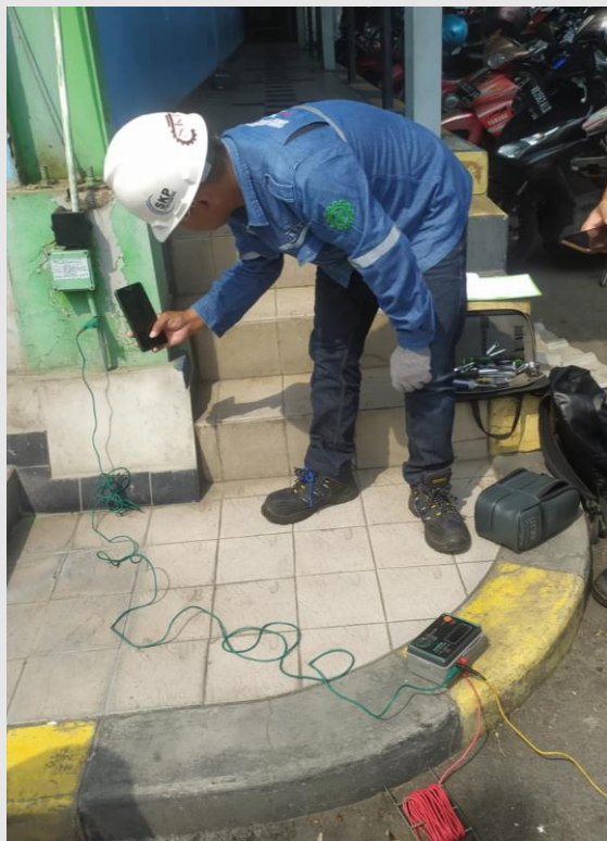
(Riksa Uji Penyalur Petir)
